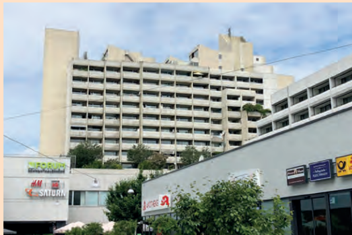
Das Gebäude Schwanthalerstraße 113
